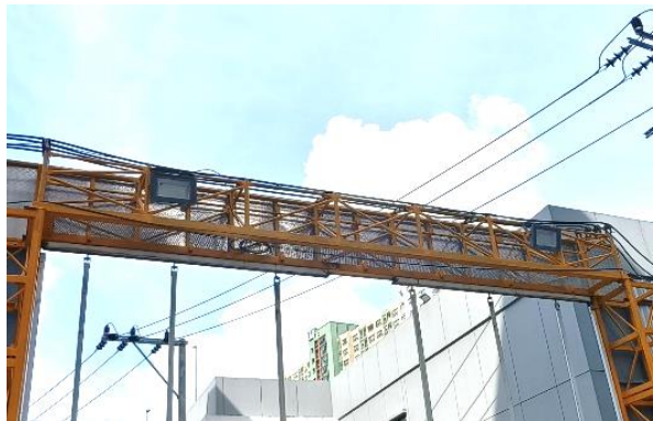
รูปที่ ก-57 ติดตั้งไฟฟ้าส่องสว่างตลอดแนวรั้วก่อสร้าง ของโครงการ
